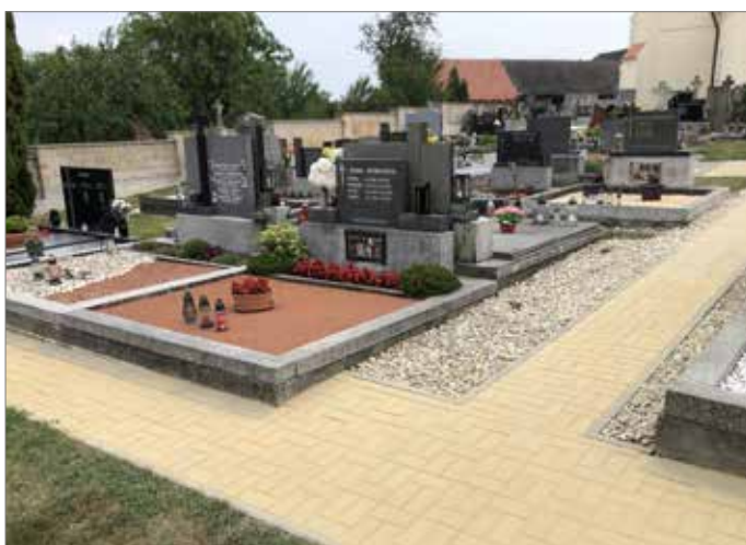
Na hřbitově nechala obec opravit chodník.
