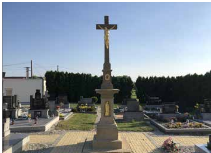
Počátkem července byla dokončena oprava kříže instalací pozlacených plastik.
