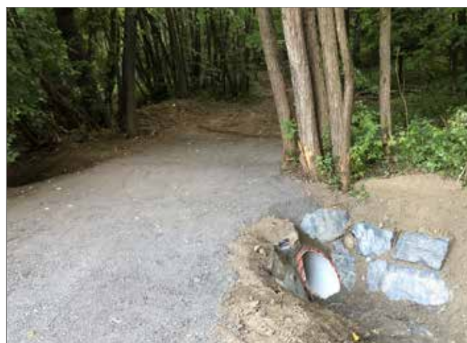
Opravené propustky konečně umožňují bezpečný vjezd do místního lesa.
