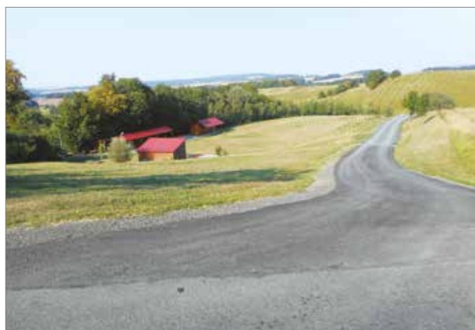
V červenci byla opravena komunikace k areálu velkoplošného hřiště.
