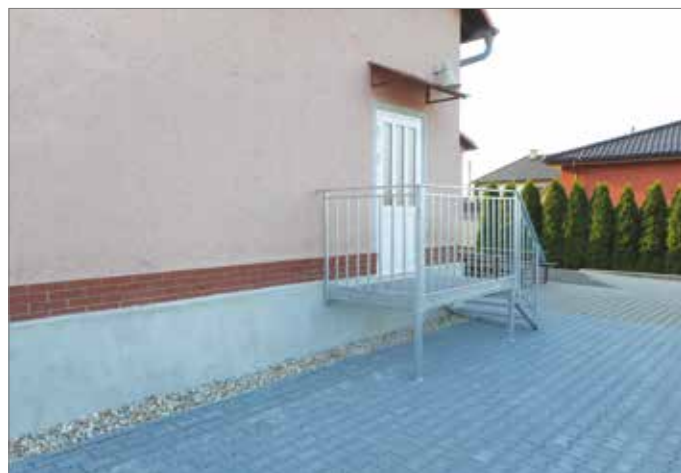
Nepotřebná a neodizolovaná terasa za KD byla odstraněna a nahrazena zpevněnou plochou a schodištěm.
