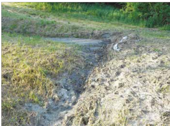
Propustek v lokalitě „Draha“, který se pravidelně ucpával, byl v červnu nahrazen novým.
